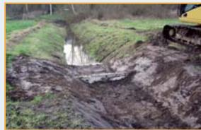
Mit festen und nicht mehr vom Landwirt zu verändernden **Stützwällen** legt der Wasser- und Bodenverband den minimalen Wasserstand für einzelne Flächen fest: Bei 30 cm unter Flur ist eine Grünlandnutzung möglich und der Moorkörper wird in den Grenzen der Nutzbarkeit geschont. In einem natürlichen Relief sind die 30 cm allerdings nur als ein Mittelwert zu verstehen, auch das auf den ersten Blick ebene Bruch hat seine Höhen und Tiefen. (Foto: WBV Welse)
