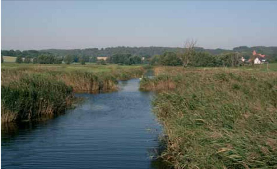
*Der Fleetgraben dient in der Neuensiener Moorniederung als Vorfluter. Er sichert die ausreichende Durchfeuchtung des Moorkörpers und führt das bei Hochwasser einströmende Brackwasser schnell wieder ab.*
