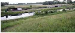
Der Parallelgraben am Deich wird kontinuierlich mit Drängewasser aus der Oder gespeist, dass aus der höhergelegenen Oder durch den sandigen Grund seinen Weg findet. Es ist von hoher Qualität und eignet sich gut für die Fischhälterung
